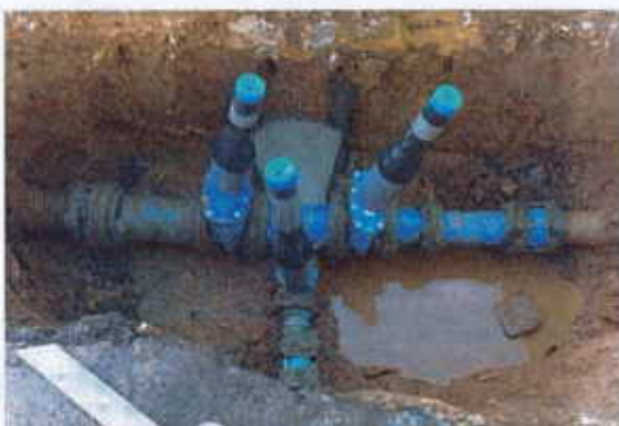
Renouvellement de vannes
