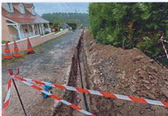
Extension de canalisation sur Presles-en-Brie
