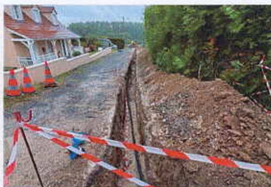
Extension de canalisation sur Presles-en-Brie
