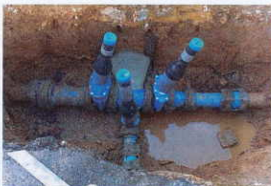
Renouvellement de vannes
